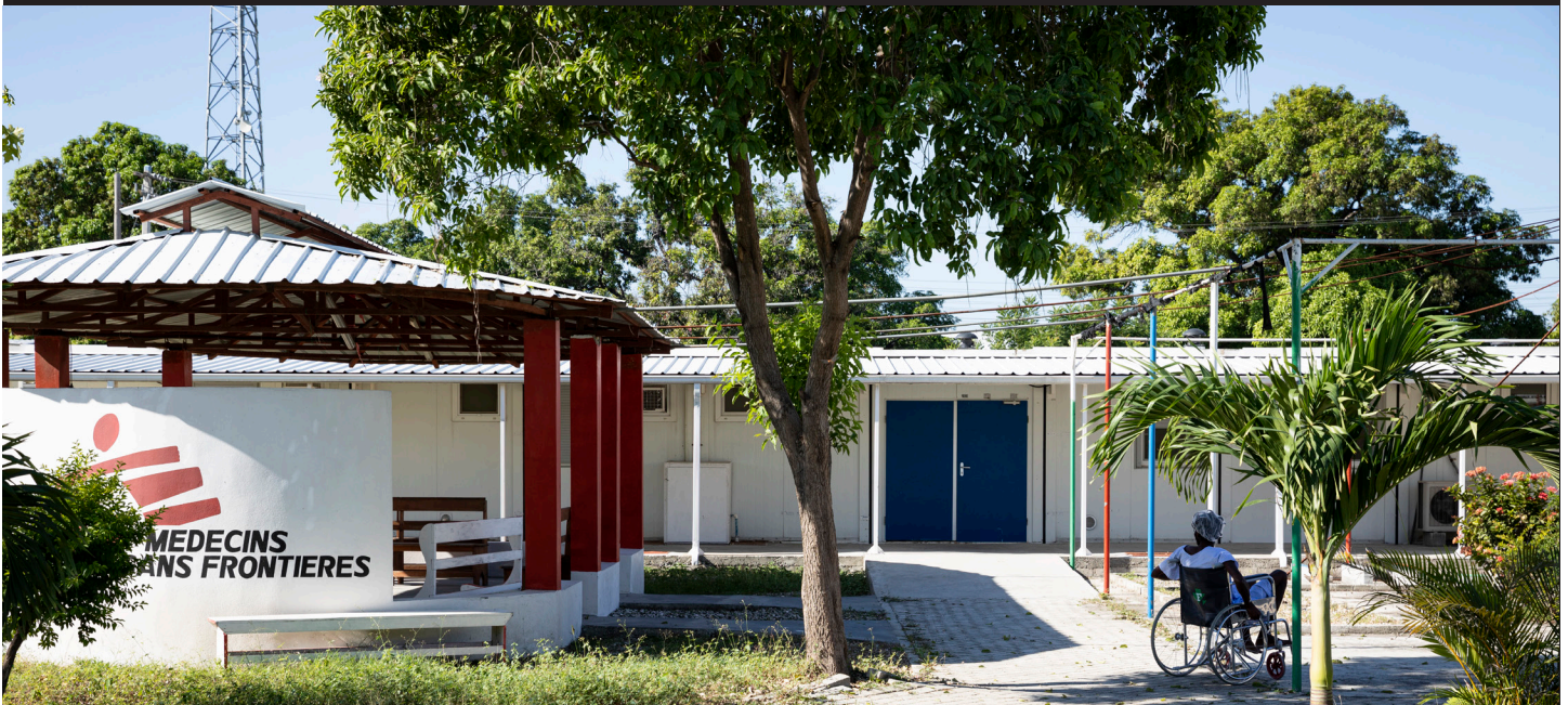
Vue du centre d'urgences traumatiques de Tabarre à Port-au-Prince. © Leonora Baumann
