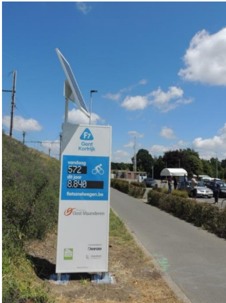
Figuur 16: fietstelpaal ter hoogte van Volderstraat in Deinze
