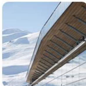
Bouwsupervisie Tignespace sportcentrum, Franse Alpen
