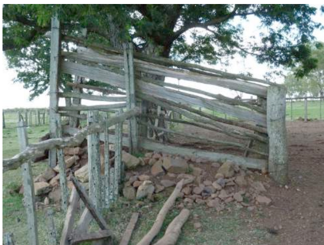
Rampe de chargement en très mauvais état
