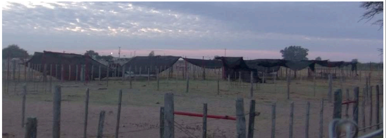
Quelques enclos ont sont munis d'un abri en mauvais état, la plupart n'en ont pas du tout
