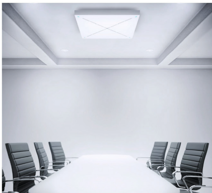
Установка на потолке
