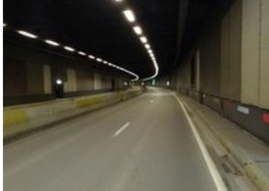
Tunnel Porte de Hal - Hallepoorttunnel
