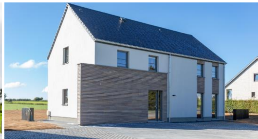
Construction en bois. ©Tom Wood
