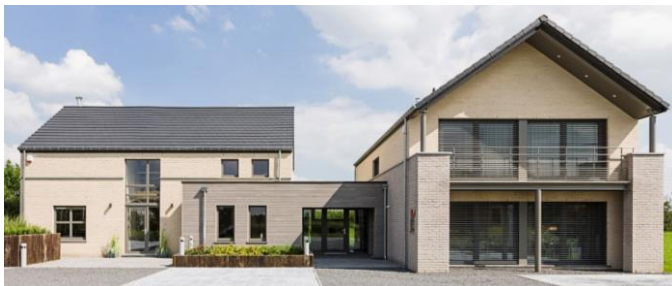
Construction traditionnelle. ©Thomas & Piron
