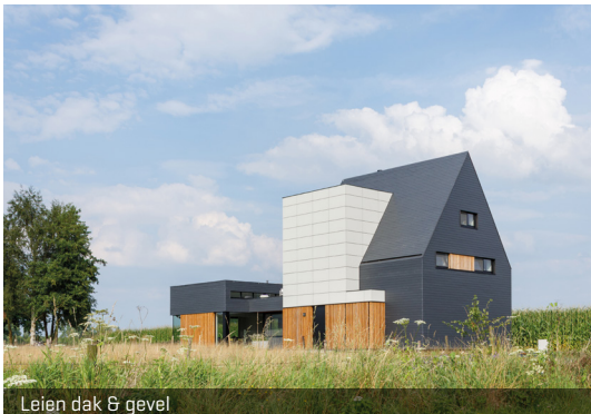
Leien dak & gevel
