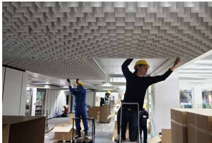
Ontmanteling van een plafond in het hoofdkantoor BNP Paribas Fortis in Brussel Dismantling of a ceiling in the headquarter in Brussels of BNP Paribas Fortis — Foto Photo Rotor
