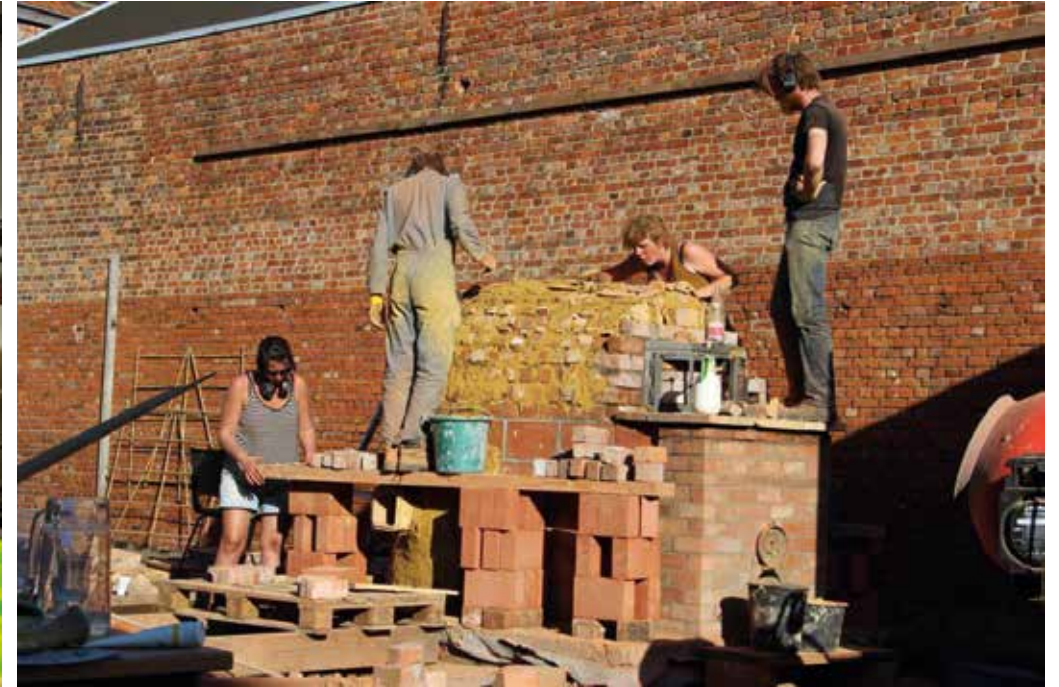
De bouw van een gemeenschappelijke bakoven op 'De Koer' bij de Brugse Poort in Gent. Buurtbewoners verdiepen zich in het bakkerserfgoed en delen verhalen en recepten.
