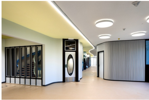
Tweede verdieping, zicht inkomzone van landschapskantoor met zicht naar de monumentale trap, na uitgevoerde werkzaamheden (H. Hermans, september 2024)
