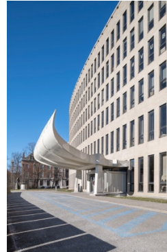
Voorgevel rectoraatsgebouw VUB na restauratie van de inkomluifel (foto T. Fischer, maart 2018)
