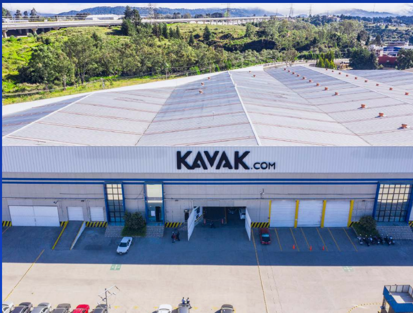
KAVAK LERMA: UNA DÉCADA CONSTRUYENDO EN MÉXICO.
