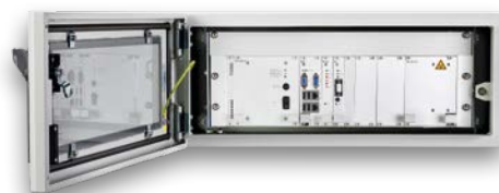
ITC2500 verbaut mit Akku im Wandschrank
