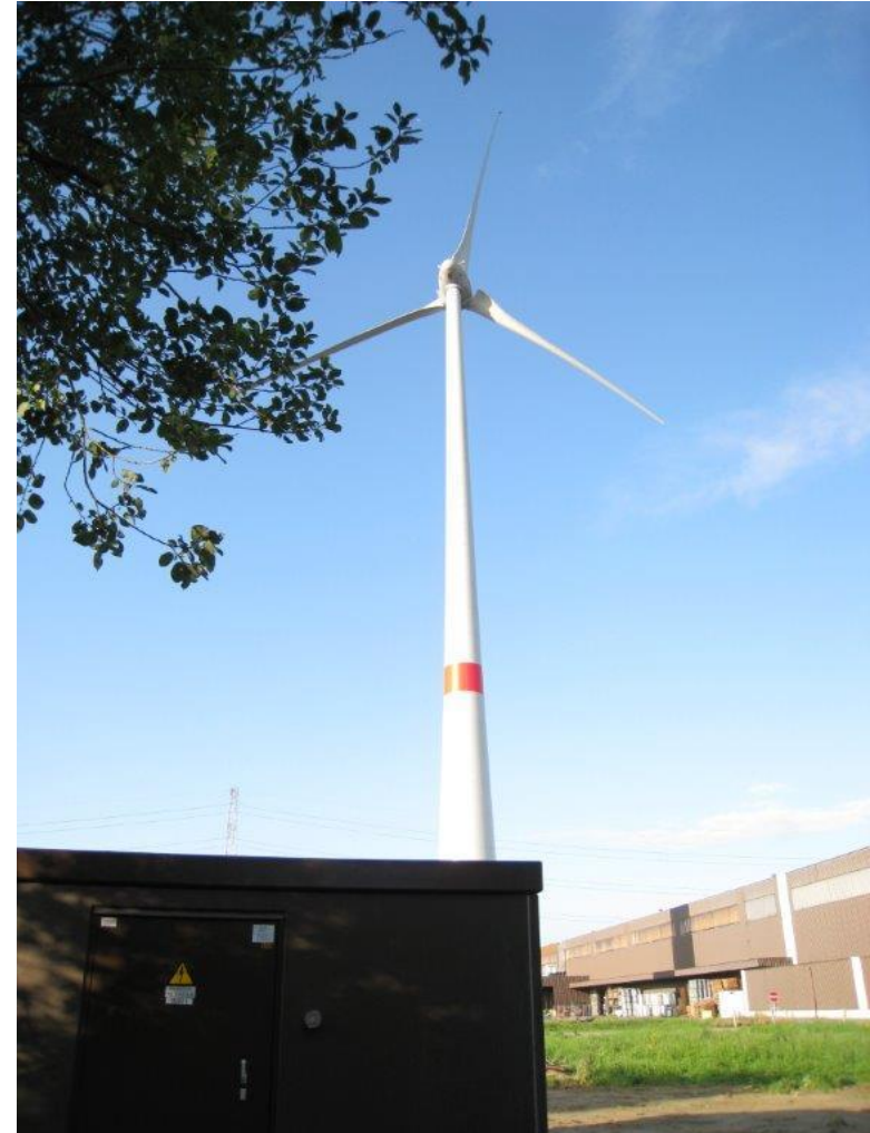
Turbine et cabine haute tension à Olen - Geel
