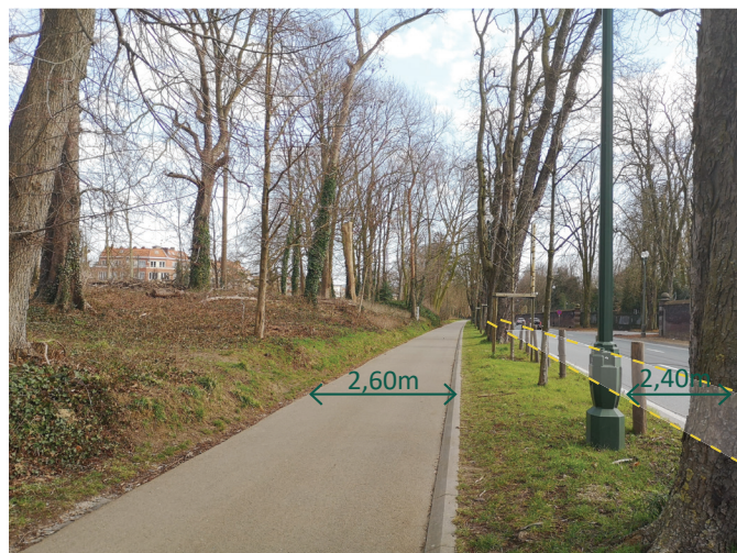
Photo du RER-vélo le long de l'avenue Van Praet
